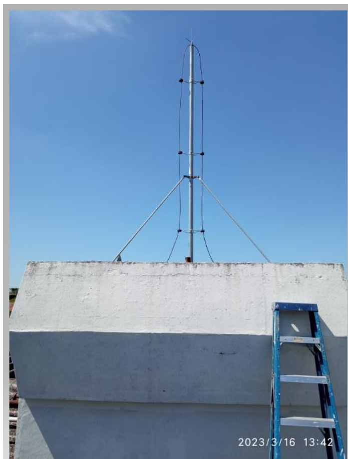
Figura 9: Vista lateral (caixa d'água com torre de Franklin)
