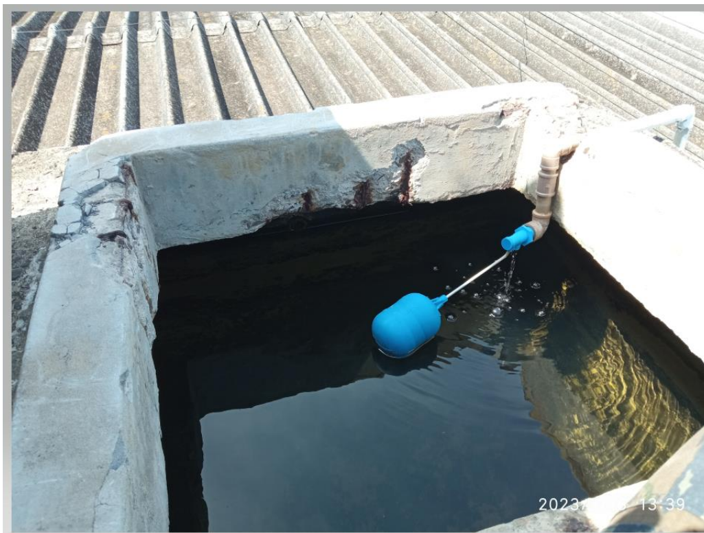
Figura 3: Patologias estruturais no alçapão
