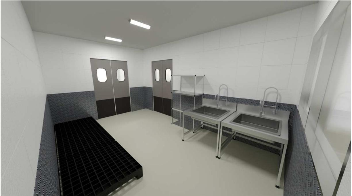
Figura 22. Exemplo de Instalação de Chapa Xadrez em áreas de manipulação
