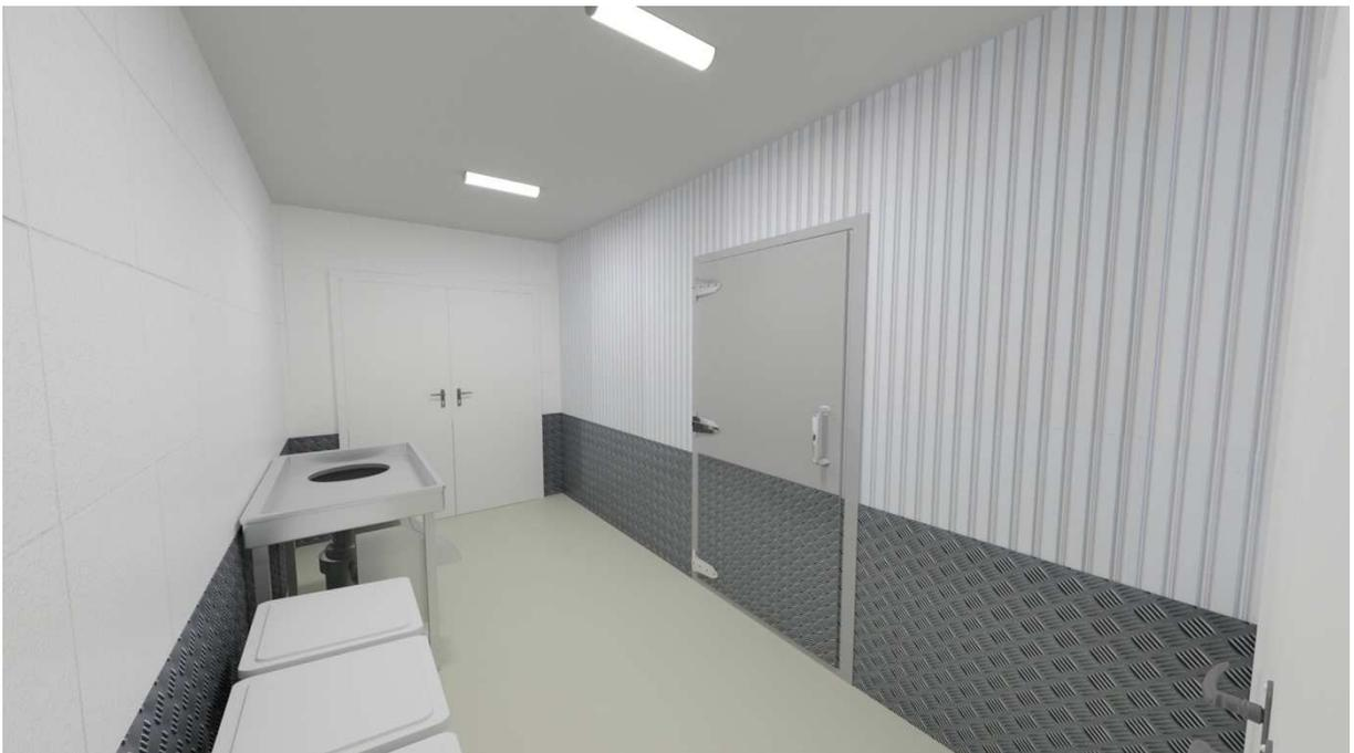
Figura 23. Exemplo de Instalação de Chapa Xadrez em áreas de circulação
