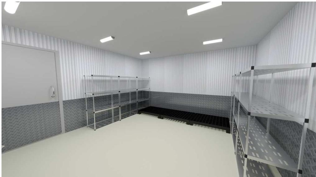
Figura 21. Exemplo de Instalação de Chapa Xadrez em câmaras frias e isopaineis
