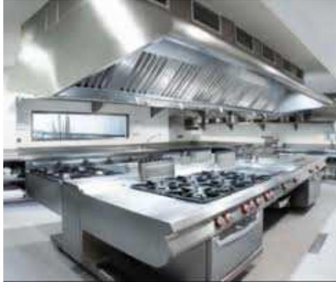
Figura 136. Sistema de Ventilação conjunto com Exaustão na Área de Cocção
