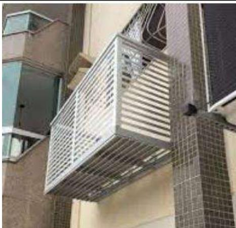
Figura 1 – Exemplo/ Similar de brise para o agrupamento das condensadoras.
