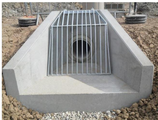
Boca de Bueiro em Concreto. Fonte: <https://www.precastdrainage.co.uk/page/concrete-headwalls>
