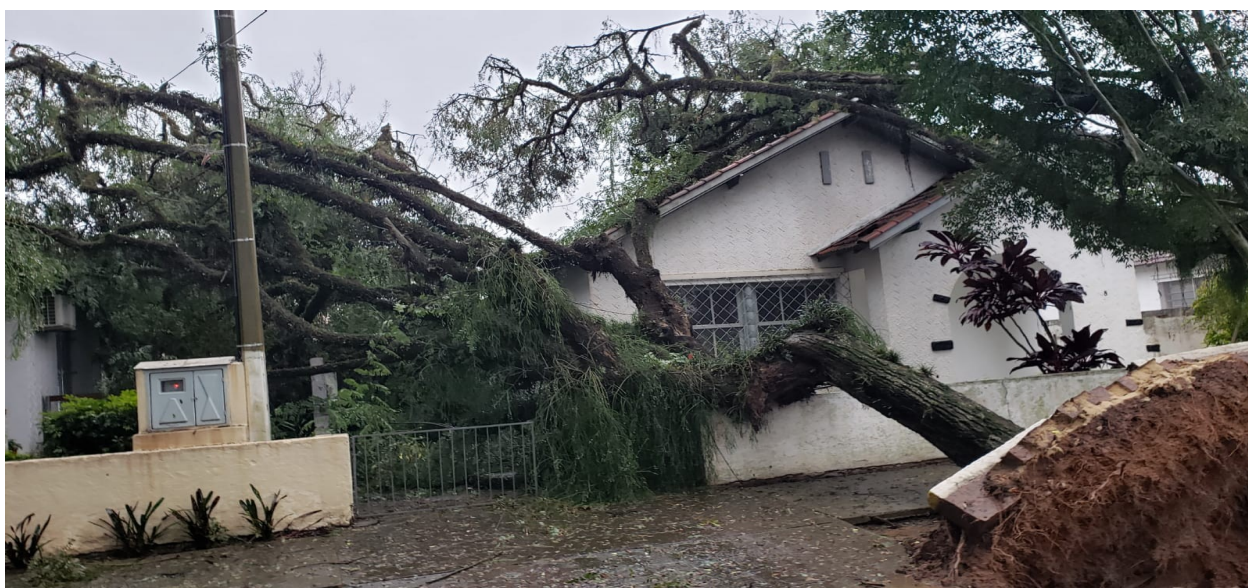
Figura 1: Árvores caídas sobre os PNR
