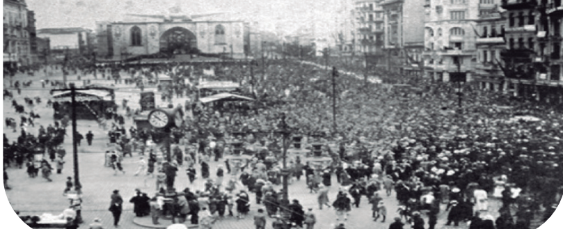
Missã na Catedral da Sé (em construção) pela chegada do Jabú, em agosto de 1927 74
