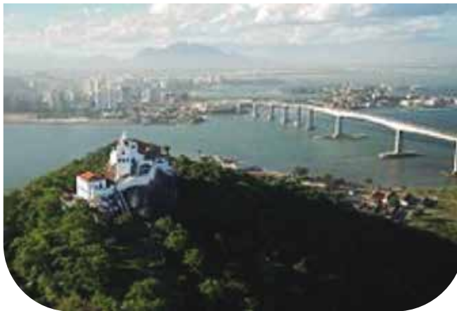
Convento da Penha, na cidade de Vila Velha, Espírito Santo
