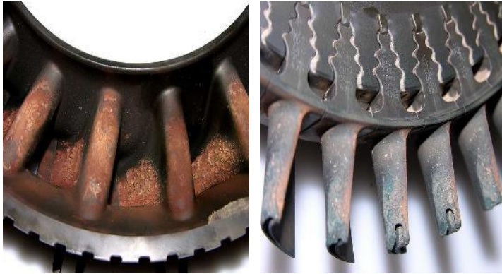
INSPEÇÃO ANTES DAS RECOMENDAÇÕES PERSONALIZADAS
