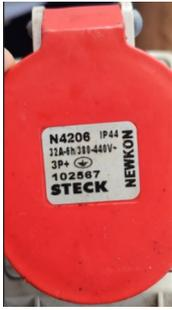
Tomada blindada 3 pólos, de sobrepor, 32A, 380V-440V e grau de proteção IP44. Construção conforme NBR IEC 60309-1: 2015, que versa sobre plugues e tomadas para uso industrial. (Ref: N4206 STECK ou equivalente)
