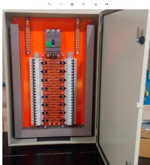
Figura 1 – Estrutura interna dos Quadro de distribuição a instalar
