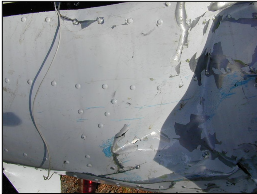
Figura 53 - Superfície vertical de uma fuselagem fotografada de lado. Observam-se marcas de arranhões, na cor azul, em linha reta, e o pequeno ângulo formado com o eixo longitudinal da aeronave, mostrando um pequeno movimento relativo vertical durante a colisão.
