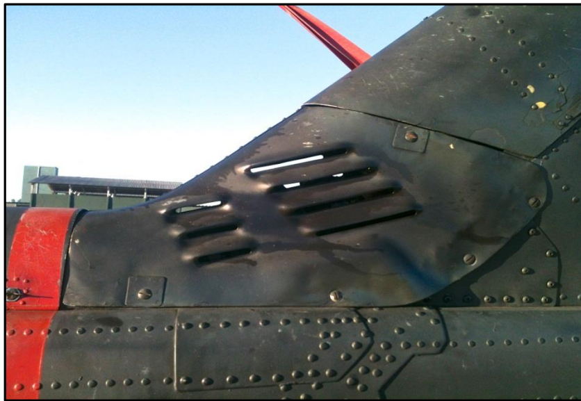
Figura 88 - Caixa de engrenagem com indício de vazamento.
