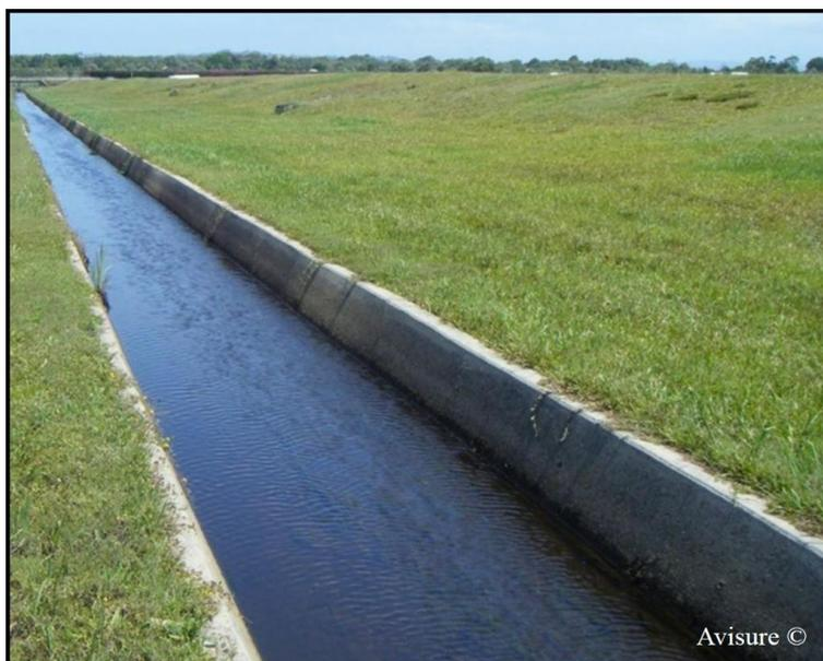
**Figura 34** – Exemplo de margem inacessível para espelhos d'água em aeródromos
