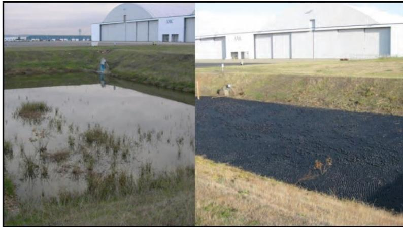
**Figura 35 – Exemplo de espelho d'água recoberto com dispositivos flutuantes**
