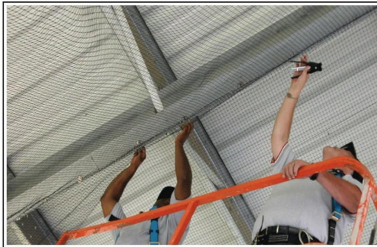
**Figura 30 – Aplicação de rede de exclusão em hangar de aeródromo**
