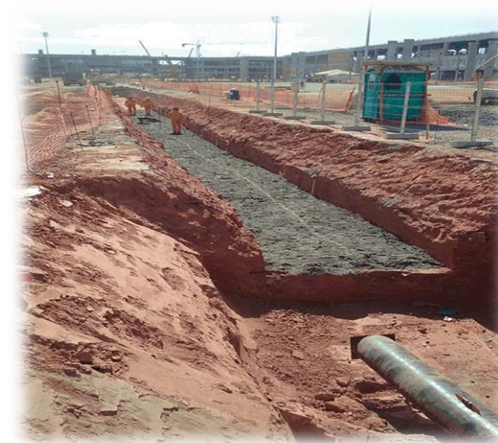
Construção da rede de hidrantes do Galeão
