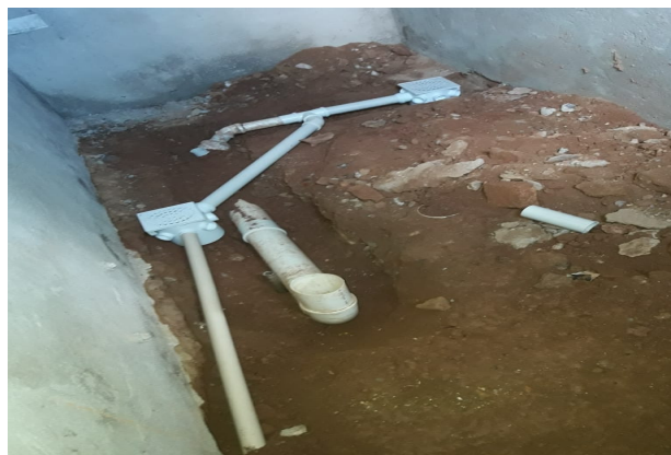
Foto 04 – Nova instalação de banheiro.
