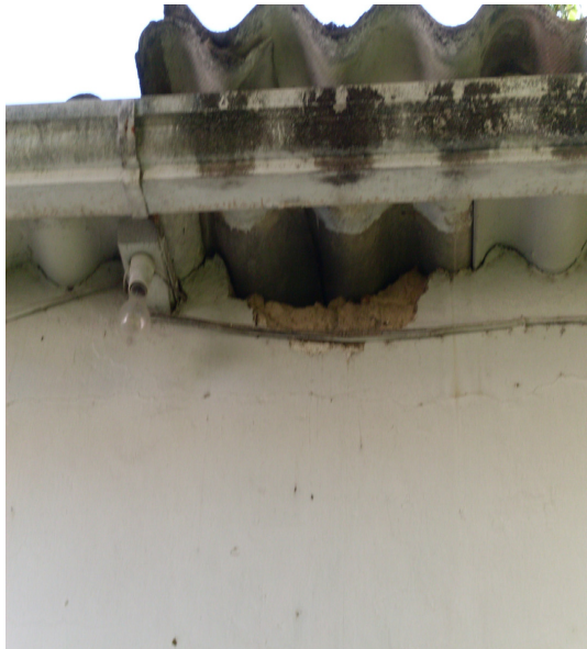
Foto 07 – Telha em fibrocimento.
