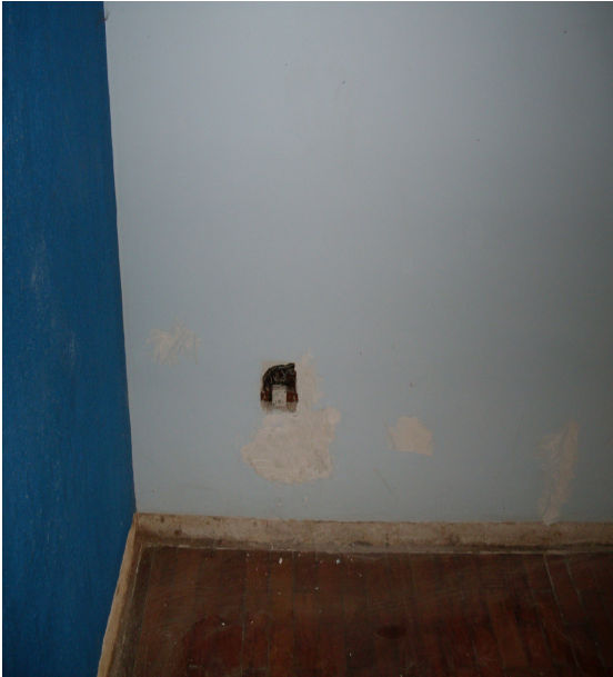
Foto 05 – Caixa de passagem galvanizada.
