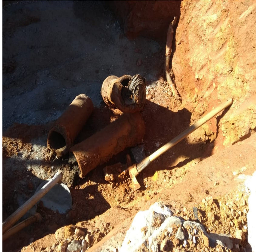
Foto 08 – Vala para execução de caixa de passagem de esgoto.
