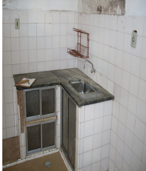
Foto 06 – Instalação elétrica em PNR.
