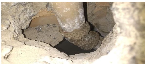
Foto 02 – Manutenção em joelho de 45°.
