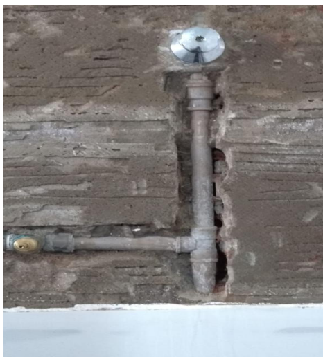
Foto 01 – Manutenção em registros de água fria.
