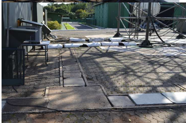
Confecção do portão de acesso
