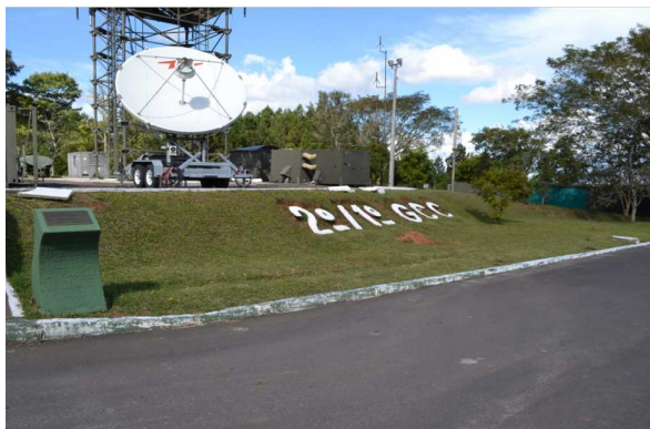
Rampa de acesso ao pátio do radar
